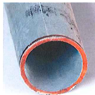
Verzinktes Stahlrohr nach Reinigung und bei optimaler Silikat-Zudosierung: eine dünne, glasartige Schutzschicht hat sich gebildet.
